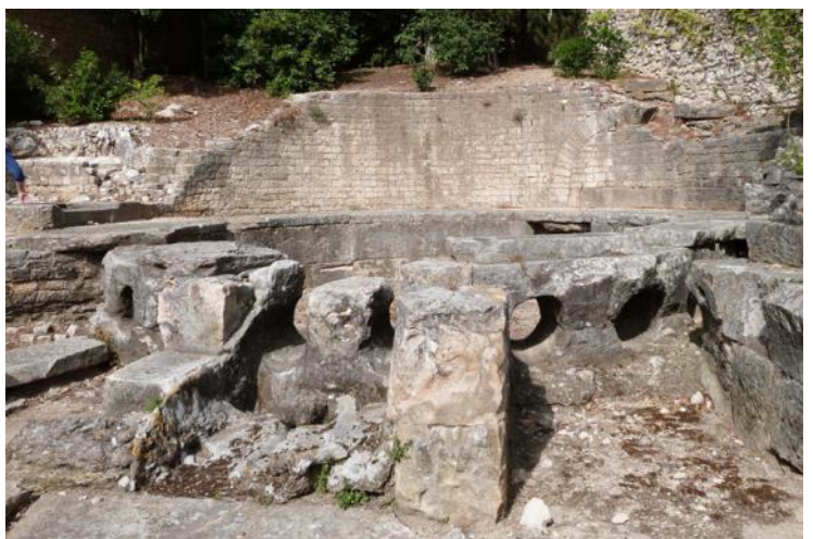
Castellum: à l'arrivée de l'aqueduc à Nîmes, le castellum distribuait l'eau aux différents usagers. On distingue les départs des canalisations principales.
