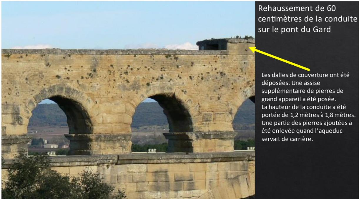
Le rehaussement de la conduite a nécessité le renfort de nombreux ouvrages que l'on remarque en cheminant le long de l'aqueduc : ils sont faits avec soin, en utilisant les mêmes matériaux que l'ouvrage d'origine. Il s'agit de la confortation de plusieurs ponts des bois de Remoulins et du bouchage d'un grand nombre d'arches. Ces modifications précoces contrastent avec d'autres plus tardives, beaucoup moins soignées.
