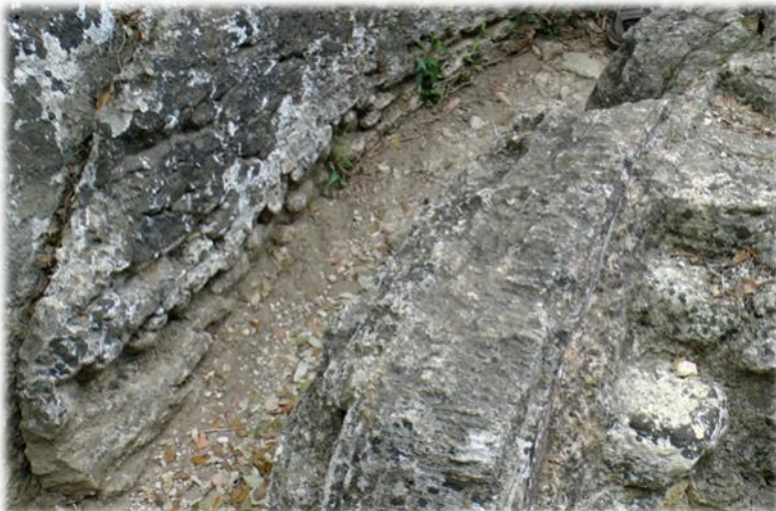
Aqueduc de Nîmes : concrétions calcaires
