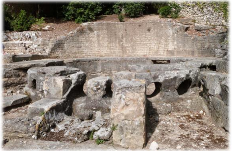
Castellum de Nîmes : A l'arrivée de l'aqueduc à Nîmes, le castellum distribuait l'eau aux différents usagers. On distingue les départs des canalisations principales.
