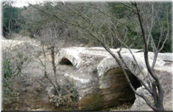
Pont de Bornègre, vue aval
