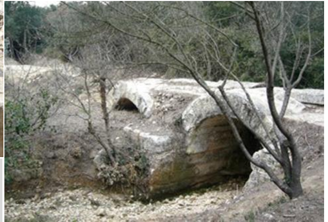
Castellum de Nîmes: à l'arrivée de l'aqueduc à Nîmes, le castellum distribuait l'eau aux différents usagers. On distingue les départs des canalisations principales.
