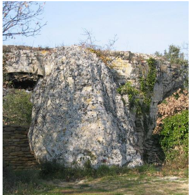
Aqueduc de Nîmes dans le site du Pont du Gard (pont Roupt): Concrétion calcaire résultant d'une piqûre pratiquée sur la conduite. Cette pratique était sévèrement punie sous l'Empire.
