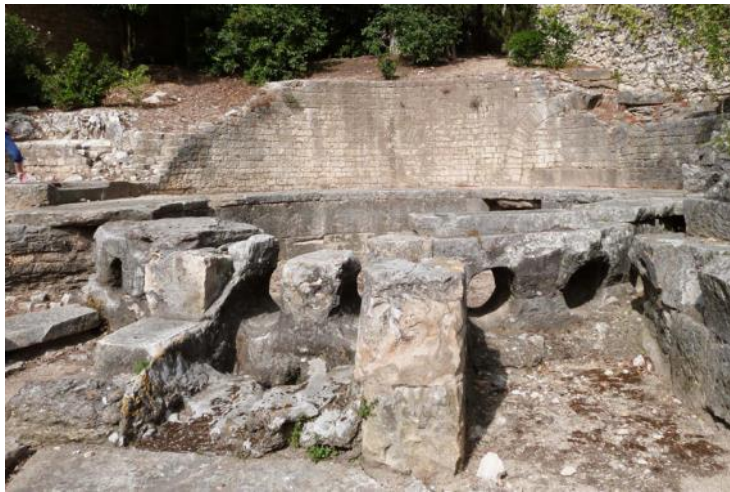
Aqueduc de Nîmes dans le site du Pont du Gard (pont Roupt): Concrétion calcaire résultant d'une piqûre pratiquée sur la conduite. Cette pratique était sévèrement punie sous l'Empire.
