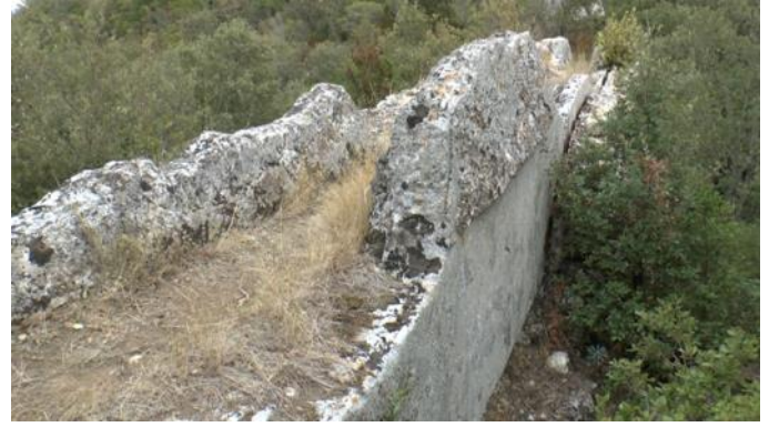
Pont de la Combe Joseph
