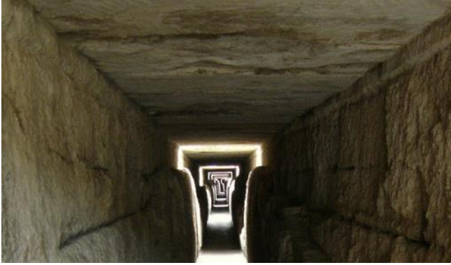
La conduite sur le pont du Gard : observez son rétrécissement
