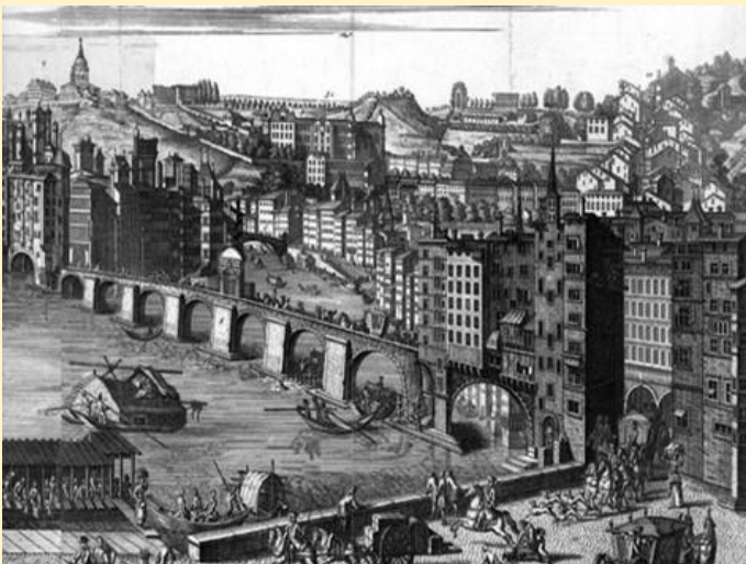
Le pont au change de Lyon sur la Saône, en service de 1070 à 1842, belle longévité pour un pont antérieur d'un siècle au pont saint Bénézet d'Avignon ! Il avait été bâti avec des pierres issues d'un précédent pont romain et il était « habité » avec des maisons de plus de quatre étages !
