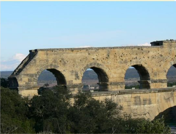
Troisième étage rive gauche: on voit le vide laissée par les arches démontées à gauche et, à droite la surélévation de la conduite (photo PdGP)
