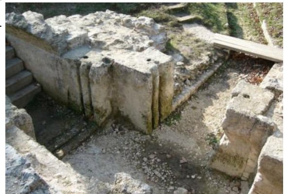
Amas de concrétion résultant d'une piqure (pont Roupt)
