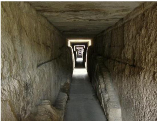
Conduite de l'aqueduc sur le pont du Gard
